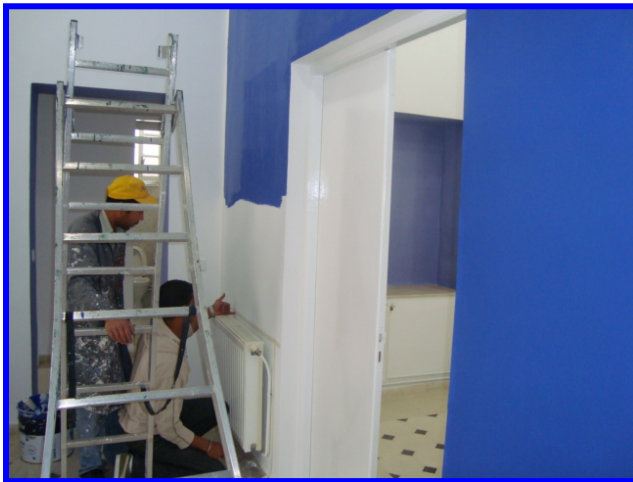
Mise en peinture du pan de mur du hall d'accueil
